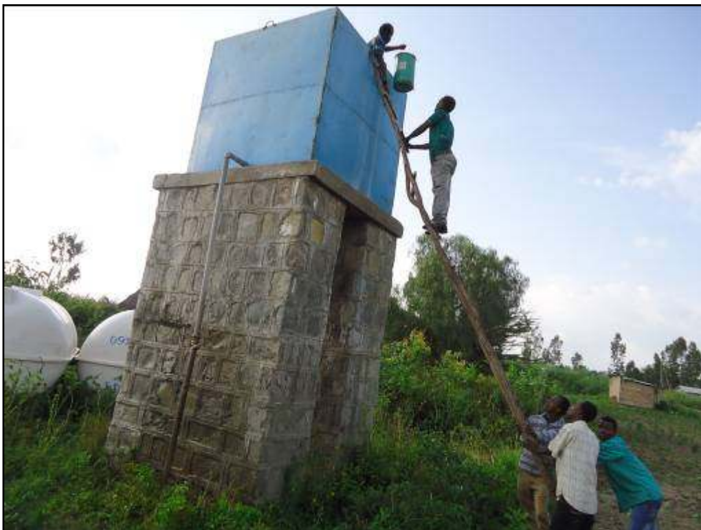
4. Desinfekce akumulčního tanku
