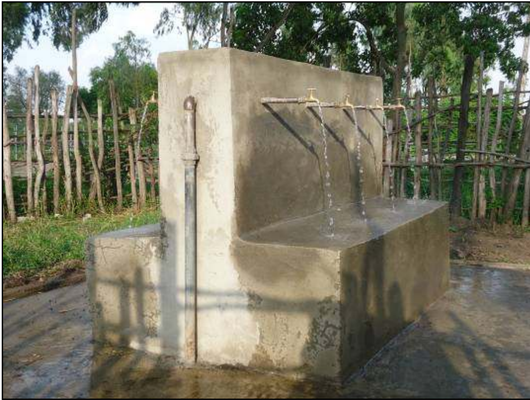
5. Zkouška veřejného odběrného místa
