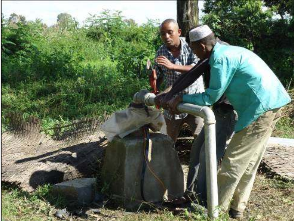
1. instalace nového čerpadla
