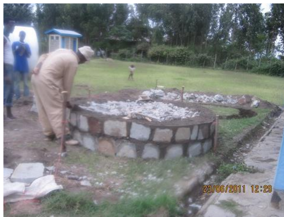
Stavba podstavce pro tank na vodu
