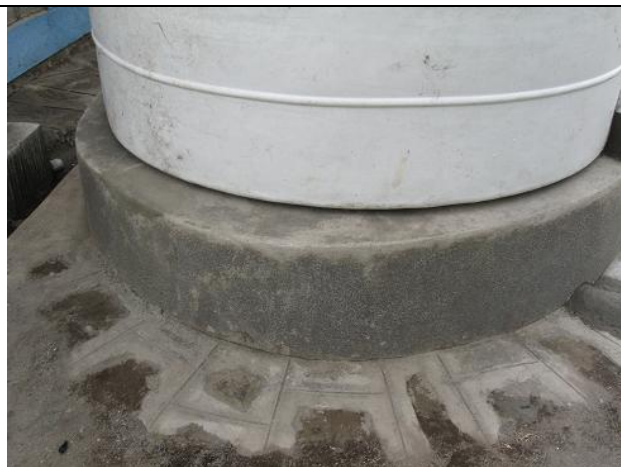
Zpevnění terénu kolem střešního lapače
