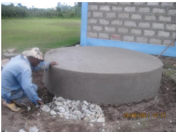
Práce na podstavci pro tank na vodu
