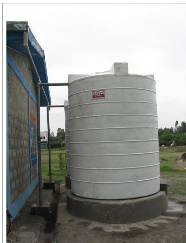
Osazené 10m 3 tanky na vodu se svodným potrubím ze střešních žlabů
