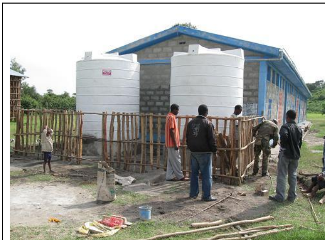
Stavba oplocení kolem střešního lapače – provedeno komunitou jako jejich kontribuce ke stavbě
