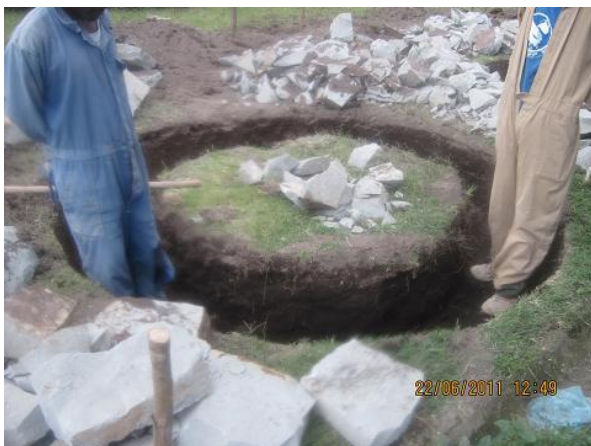
Výkop pro základy střešního lapače
