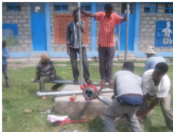
Řezání potrubí, které svádí vodu ze střešních žlabů do tanků
