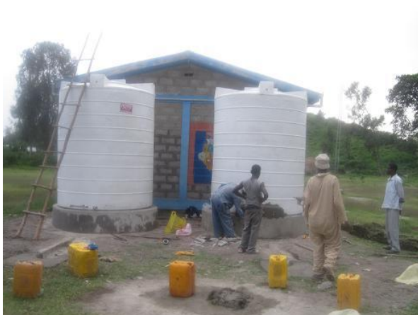
Osazování 10m 3 tanků na vodu
