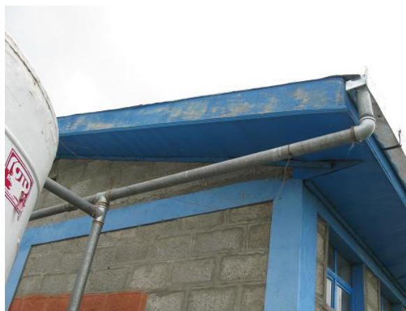
Svodné potrubí ze střešních žlabů
