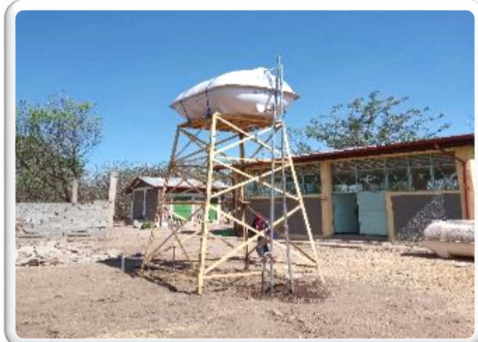
Foto 1: Instalace 2m 3 sklolaminátové nádrže na stávajícím stojanu
