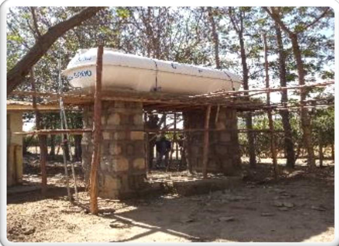
Foto 3: Konstrukce 2 m vyvýšeného podstavce nádrže, instalace 5m 3 sklolaminátové nádrže v Makabasa ZC, 2021
