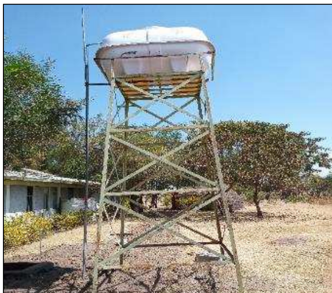
Foto 7: Instalace 2m 3 sklolaminátové nádrže na stávajícím stojanu v Umbulo Tanakaka ZC, 2021
