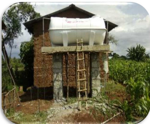
1 – Nádrž ve škole Argeda
