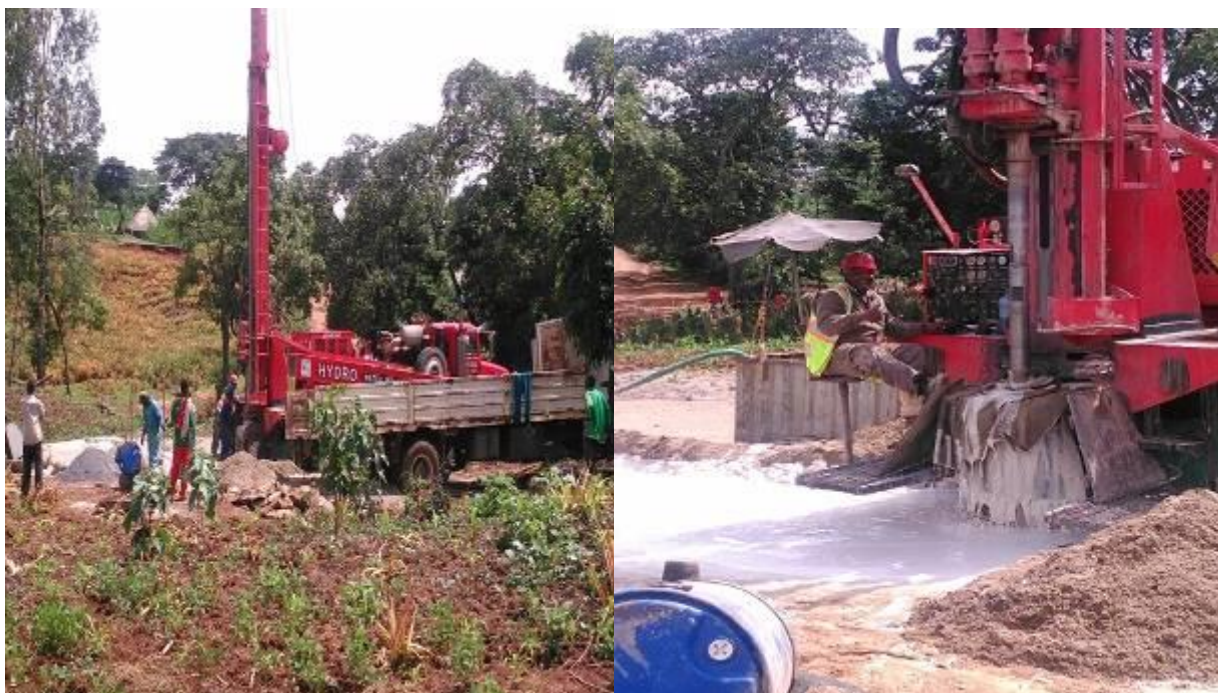
Vrtání hlubokého vrtu v lokalitě Teso - průběh prací
