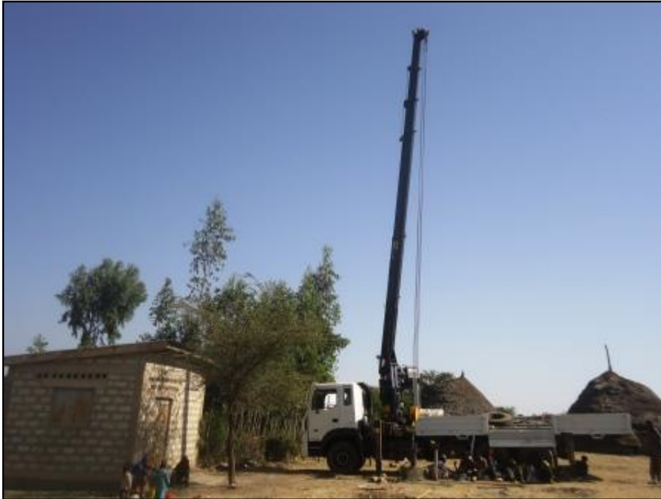
Instalace nového čerpadla
