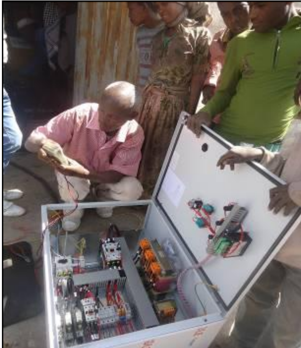
Zapojování rozvodné skříně
