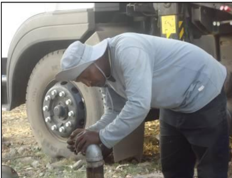
Instalace tlakového potrubí
